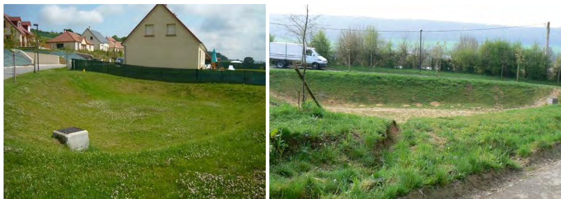
Bassins d'infiltration du lotissement
