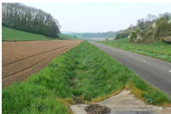
L'exutoire du bassin vers le fossé et un chemin servant de drain au plateau
