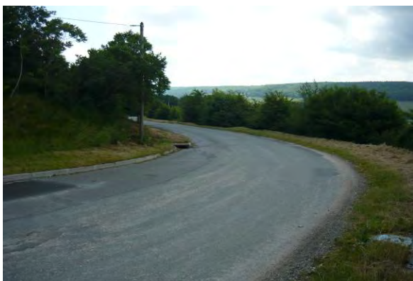
Avaloir dans le virage et parcelle en contrebas recevant les écoulements
