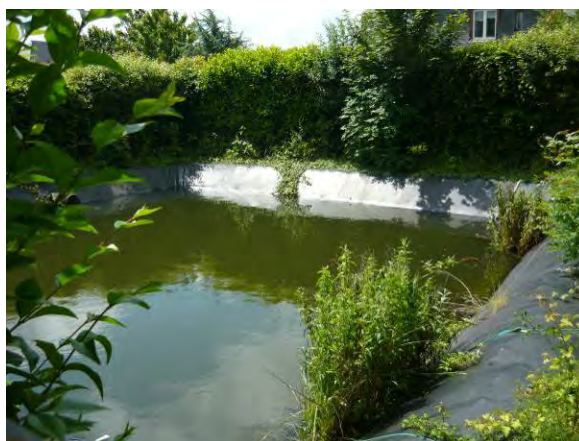
Bassin de gestion collective des eaux pluviales d'un lotissement du plateau
