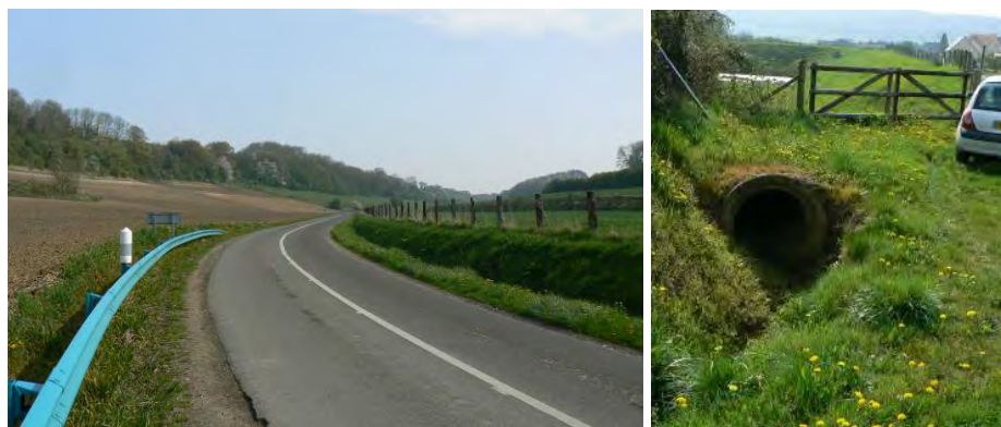
L'aval du fossé et la buse d'entrée du bassin
